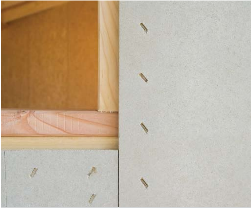
Duripanel –monteret med klammer
